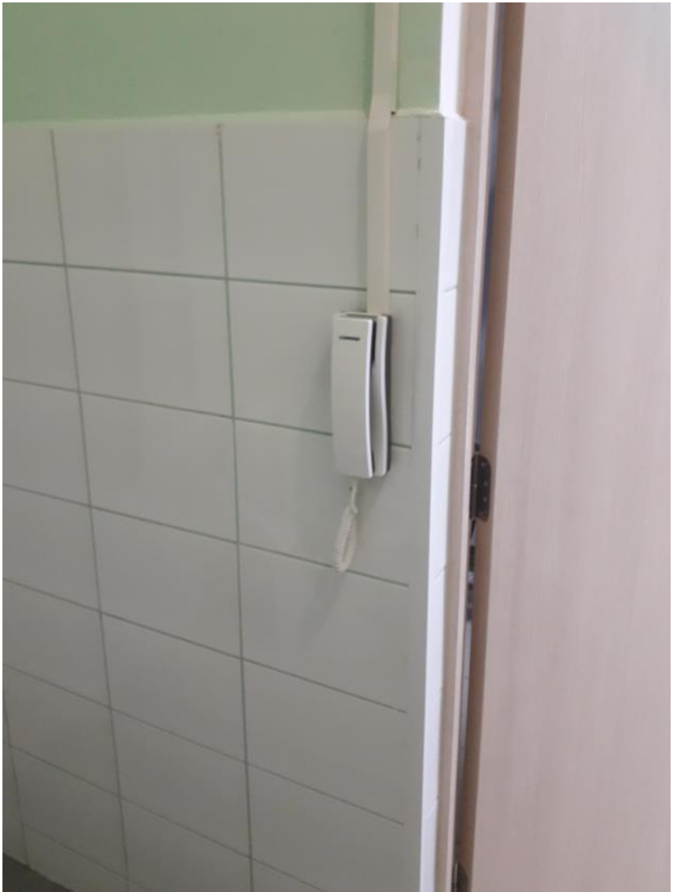
Переговорное устройство в туалете для ММГН.
